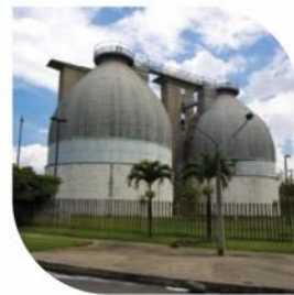
Biodigestores PTAR San Fernando
