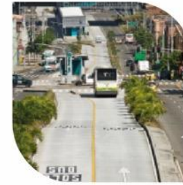
Adecuación de la Calle Barranquilla Sistema Metroplus
