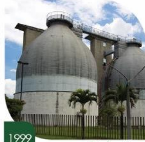
1999 Biodigestores Planta San Fernando Medellín
